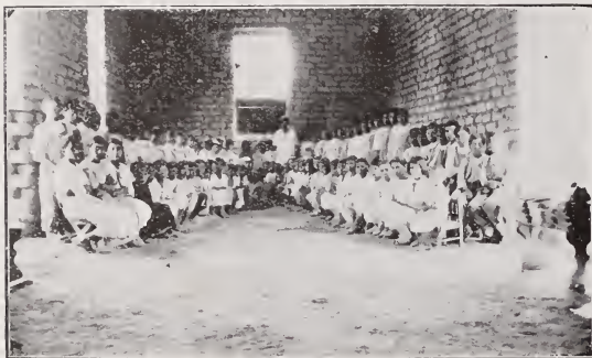
ESCUELA RURAL DE "POCITOS," SAN LUIS POTOSÍ, INTERIOR DEL EDIFICIO EN CONSTRUCCIÓN
